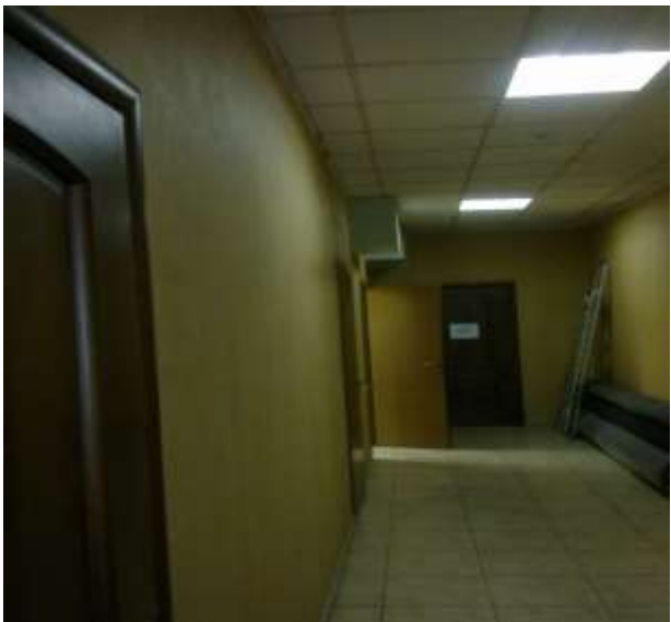
Фото 7. Помещения общего пользования
