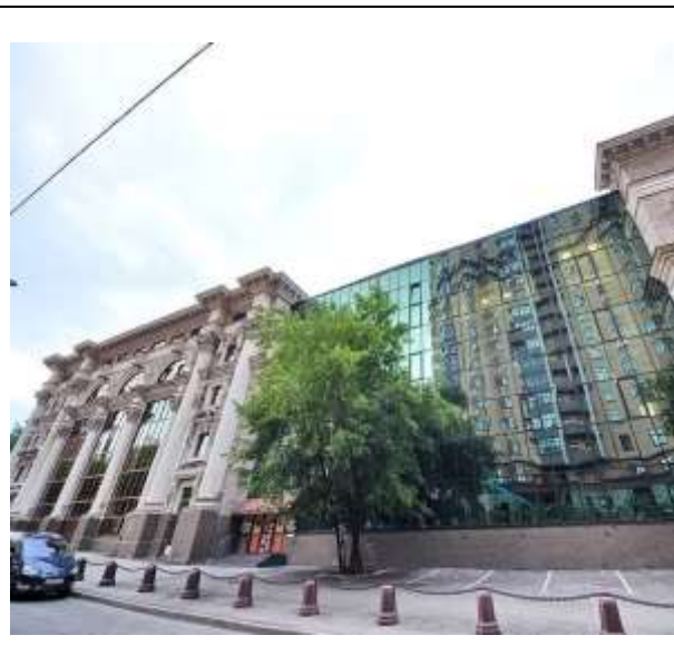
Фото.2 Нежилое здание, расположенное по адресу г. Москва, наб. ТУПОЛЕВА АКАДЕМИКА, д. 15, корп. 2
